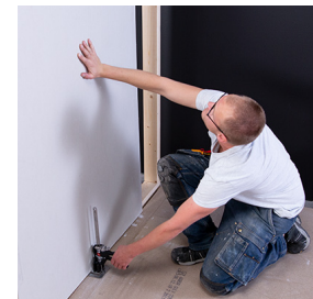
Install dry walls, panels, and glass or stone walls. Installation de cloisons sèches, panneaux et murets de verre ou de pierre.
