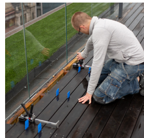
Flooring and building of decks, porches, patios. Installation de sols et construction de terrasses, de vérandas et de patios.
